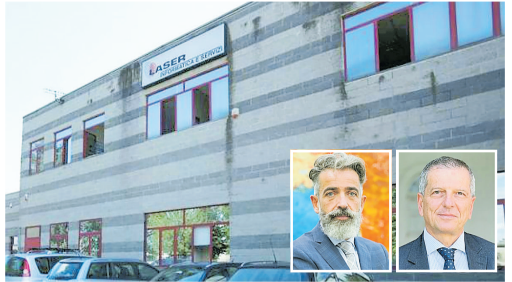
Laser nella sua sede di Strambino, in via Ivrea, e nelle foto piccole Bellinzona e Conta (a destra)
